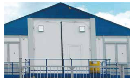
Закрытое распределительное устройство ЗРУ-СЭЩ 20/6 (6/20) кВ
