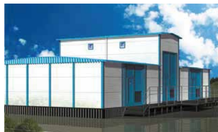
Закрытая подстанция 35/20 (10-6) кВ
