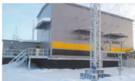
Закрытое распределительное устройство с КРУЭ -110 кВ
