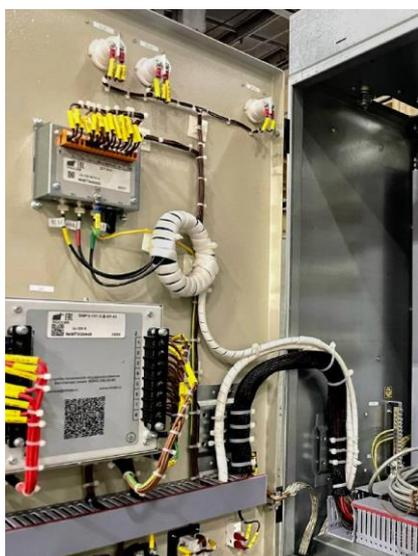
Рисунок 7 – Вид двери РШ со стороны монтажа
