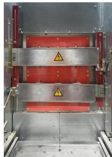
Рисунок 4 – Шторочный механизм в отсеке ВЭ
