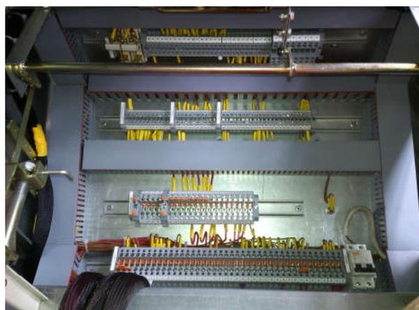
Рисунок 8 – Пример размещения клемм на панели в зоне размещения вторичного оборудования
