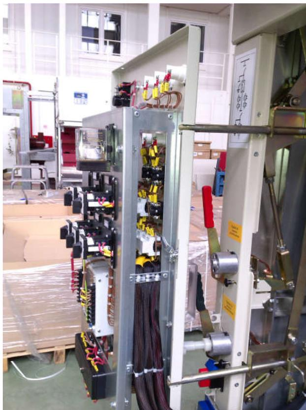
Рисунок 10 - Дверь в выдвинутом положении и открытая на 180 градусов
