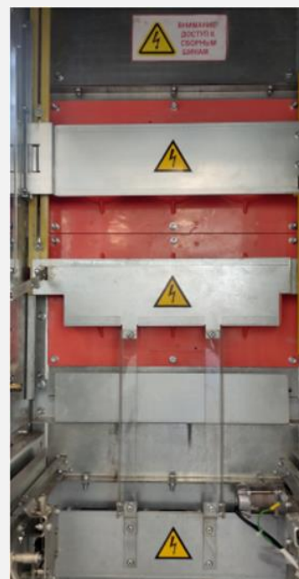
Рисунок 5 – Шторочный механизм в отсеке ВЭ
